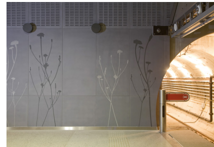
4-es metró szálerősített betonszerkezete
