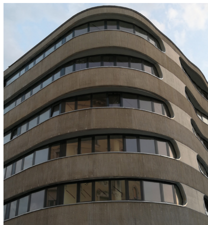
Meininger Hotel elvékonyított, íves falszerkezete
